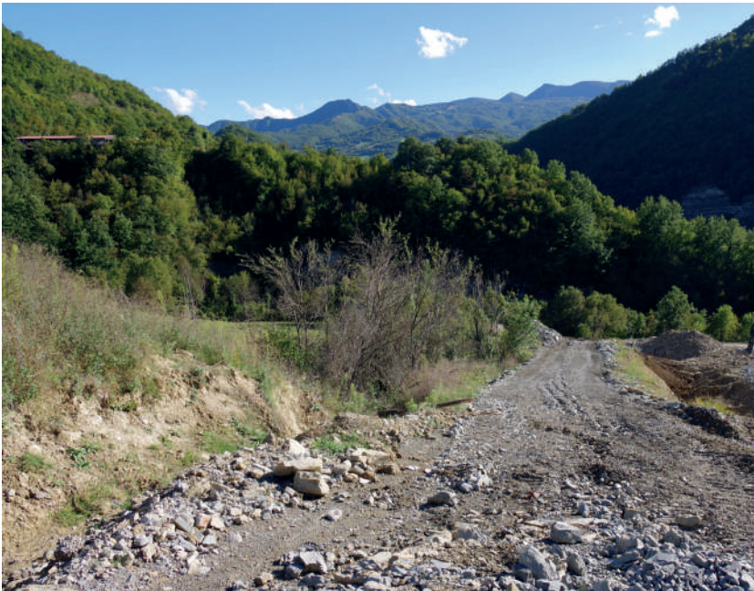
⑤ Viabilità e fosso lungo la fascia boschiva residua
