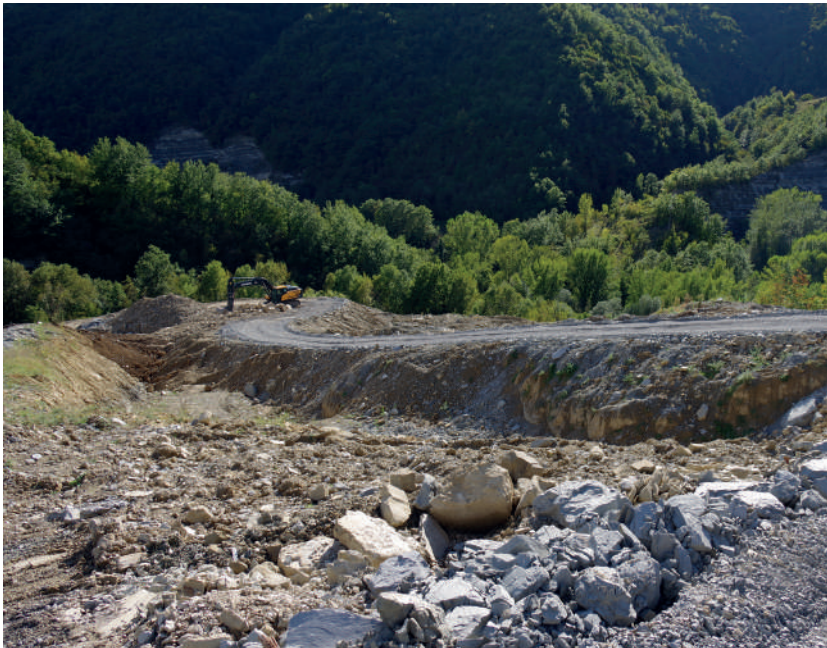
② Viabilità e mezzi durante la fase estrattiva
