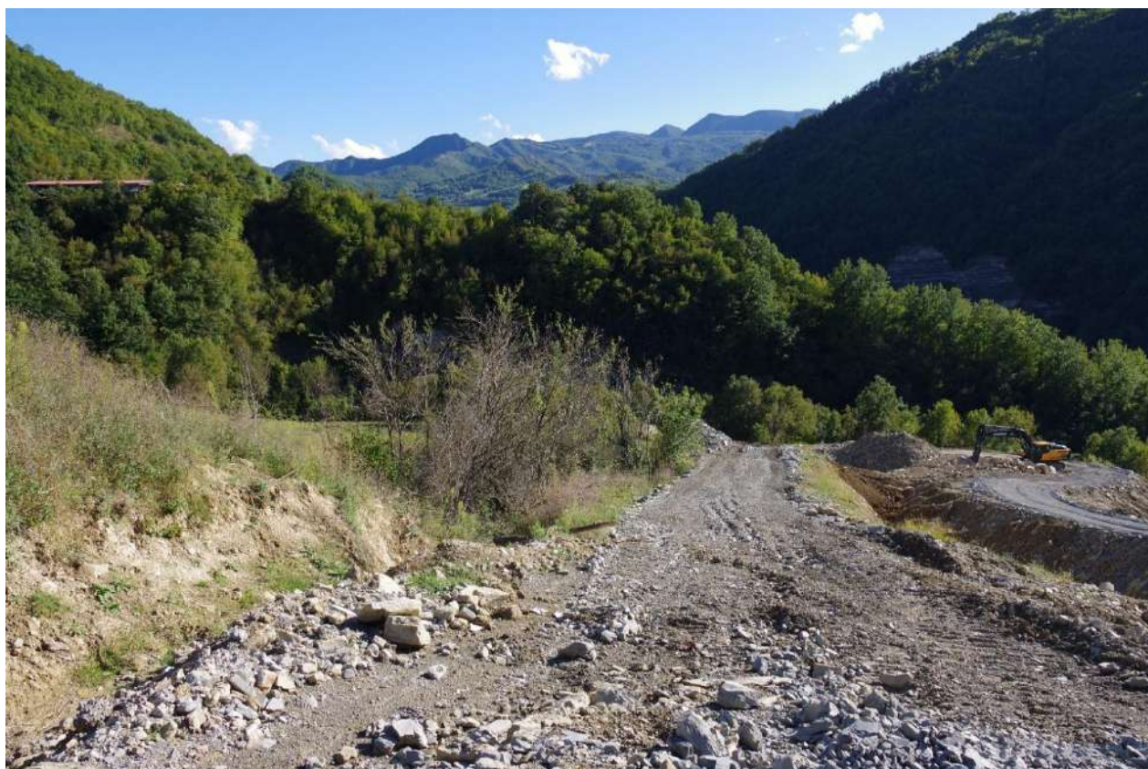
Foto 5 – Viabilità lungo il fosso e la fascia boschiva residua. Sullo sfondo i fabbricati del laboratorio di laboratorio della pietra della ditta FABRIZI
