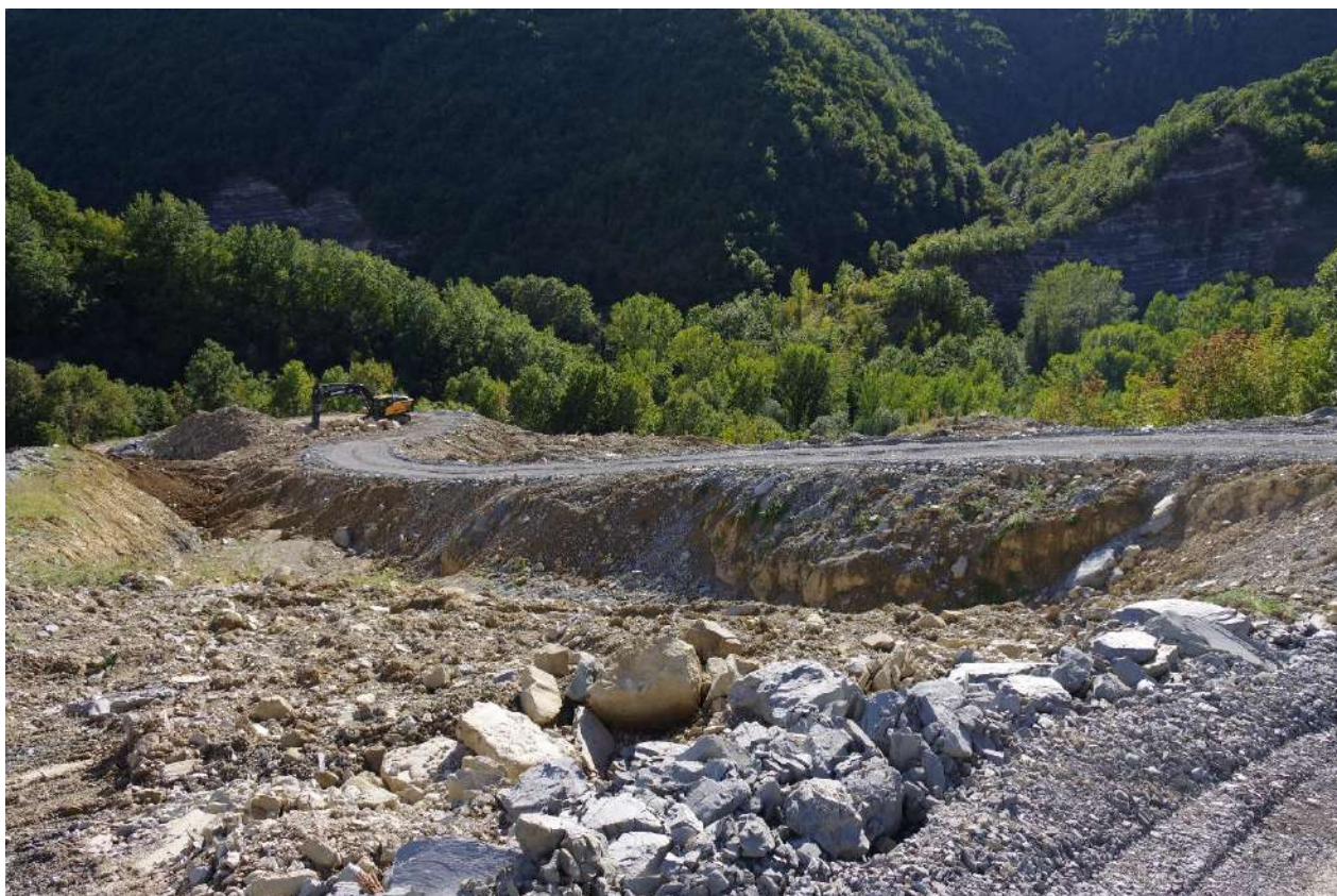
Foto 2 – Viabilità e mezzi durante la fase estrattiva
